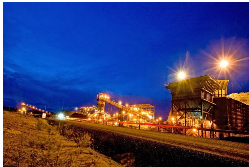
Coppabella煤矿选煤厂
